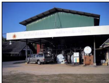
สถานีจ่ายน้ำมันไบโอดีเซล
