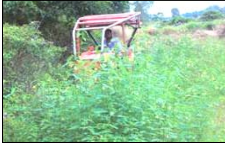
เปิดป่าและปรับเตรียมพื้นที่
