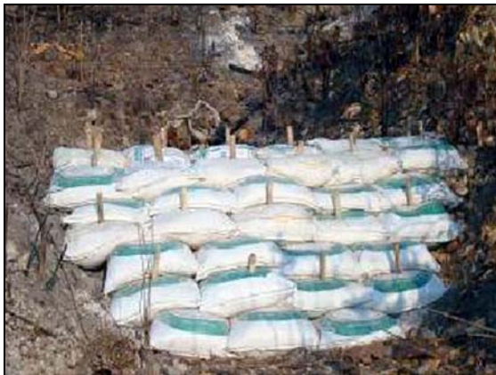
อาคารชะลอน้ำ
