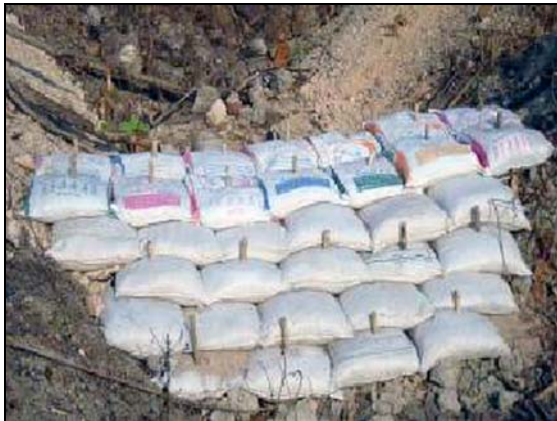
อาคารชะลอน้ำ
