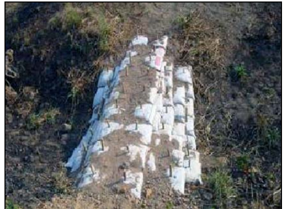
อาคารชะลอน้ำ
