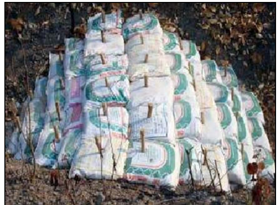
อาคารชะลอน้ำ
