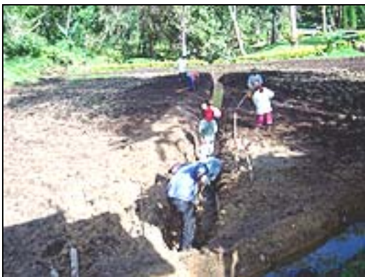
แก้ปัญหาพื้นที่น้ำท่วมขังโดยการขุดคูระบายน้ำ
