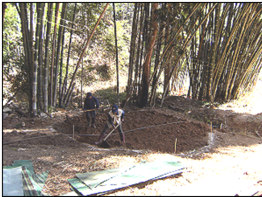
ก่อสร้างศาลาเรียนรู้งานพัฒนาที่ดิน
