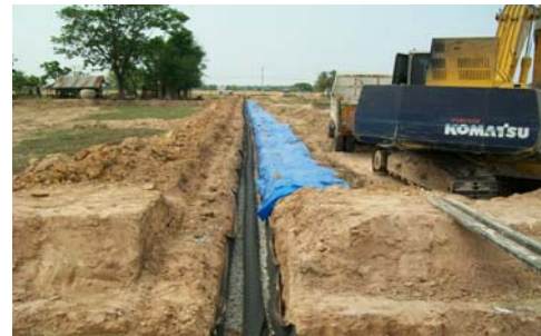
ผังแสดงการติดตั้งท่อระบายน้ำใต้ดินและคูระบายน้ำหลัก(Main Drain)
