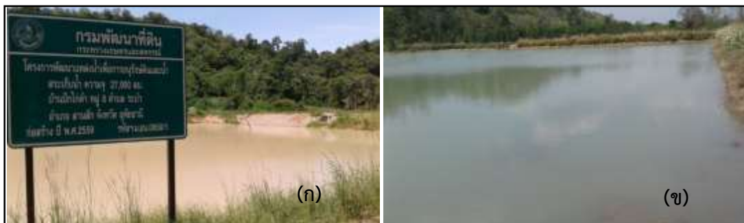
ภาพที่ 1 โครงการพัฒนาแหล่งน้ำเพื่อการอนุรักษ์ดินและน้ำ สระเก็บเก็บน้ำ ความจุ 27,000 ลูกบาศก์เมตร บ้านปึกไก่อดำ หมู่ 8 ตำบลระบำ อำเภอลานสัก จังหวัดอุทัยธานี (ก,ข)
